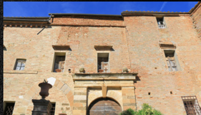
F acciata dell'ingresso principale The front facade of main gate
