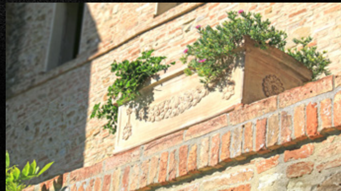
M ura della facciata frontale Walls of the front side
